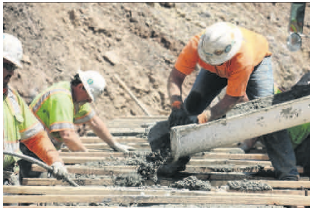
Ladd creek culvert concrete pour.
