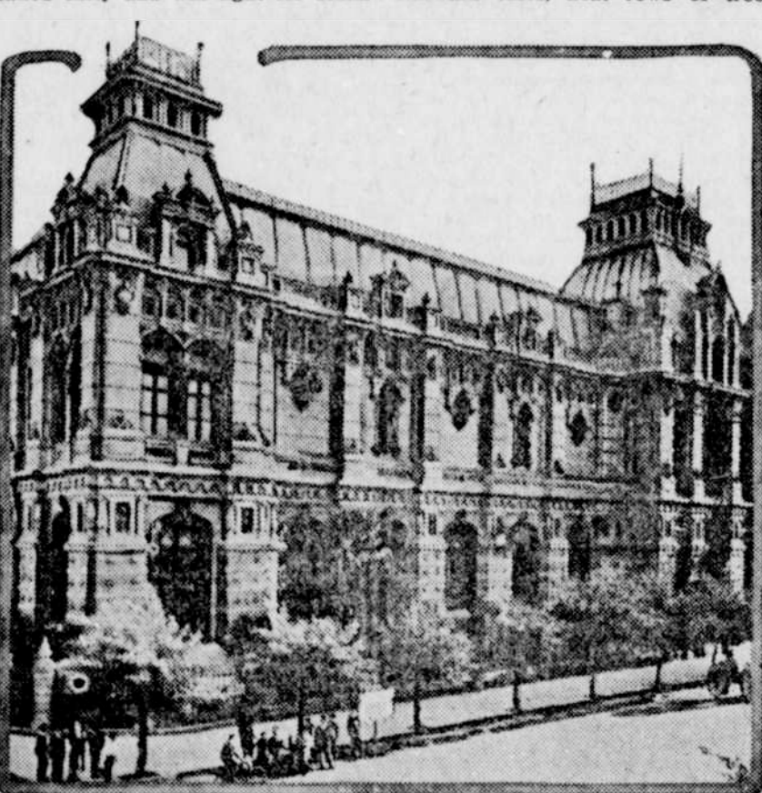
LAS AGUAS CORRIENTES, BUENOS AIRES
