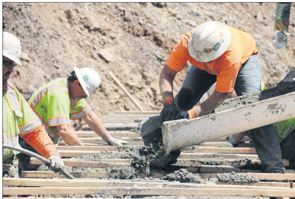
Ladd creek culvert concrete pour.
