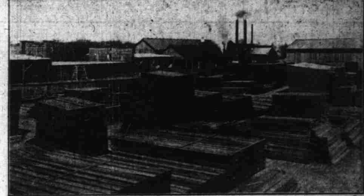
Silvertown Lumber Co.
