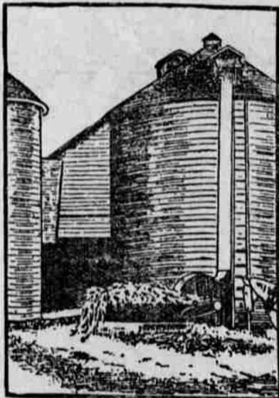
FILLING THE SILO.
