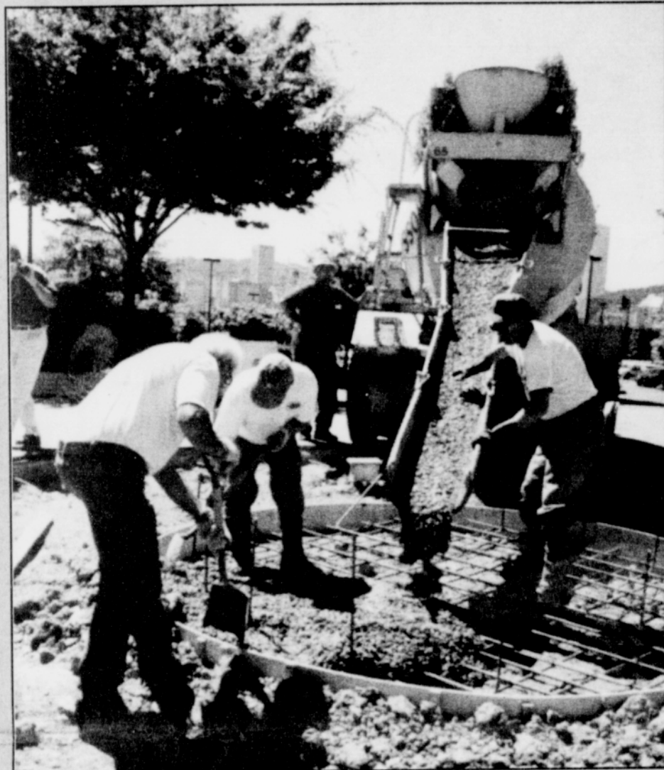
Workers pour the foundation for Martin Luther King monument.
