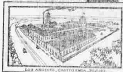
LOS ANGELES, CALIFORNIA, PLANT
